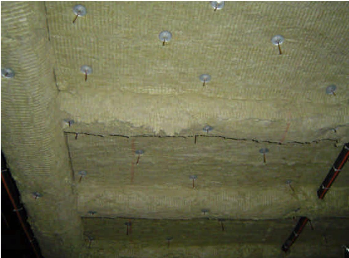
**Figura Nº 15 Foto de lana de roca volcánica instalada.**
