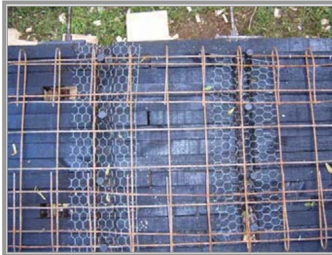
**fot 8.5** vista superior de la armadura sobre el tablero de madera.
