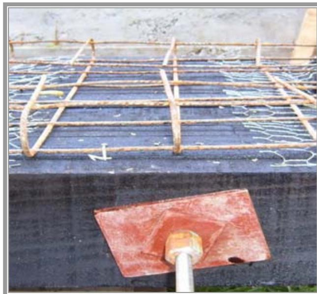
**fotg 8.6** vista lateral de la armadura sobre el tablero de madera.
