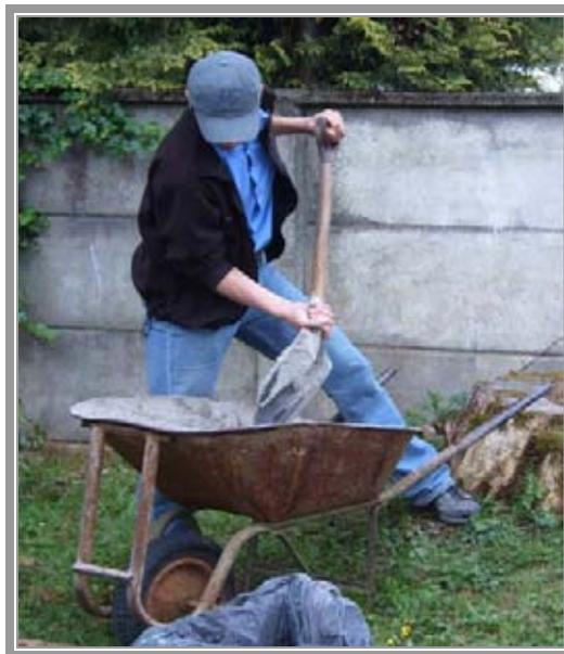
**foto 8.9 trabajo de mezclado manual de los materiales.**
