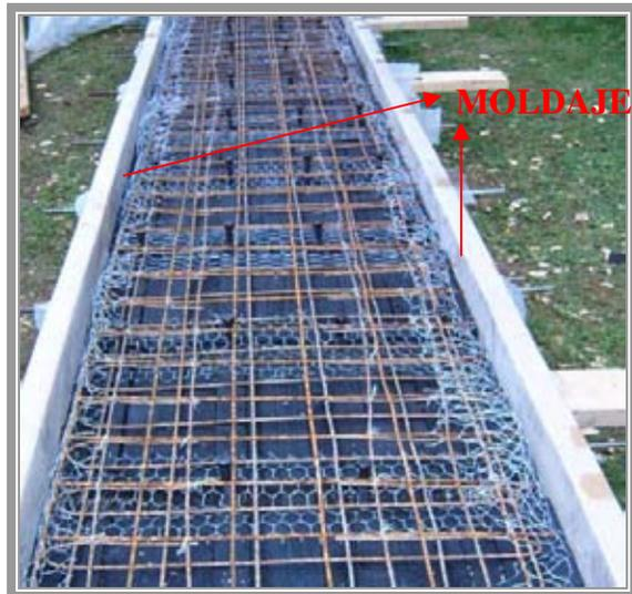
**foto 8.8 disposición del moldaje .**
