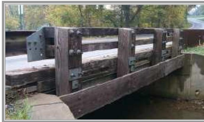
**fig. 3.1 puente de madera postensada en zona rural.**
