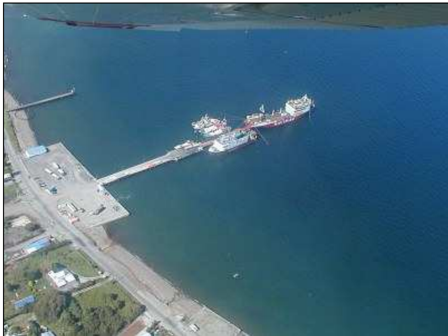
Foto 2: Vista aérea de las instalaciones
