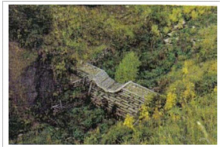
Figura 5.2: Dique de Mampostería de Trozas, Quebrada Las Lenguas. Construido por CONAF en 1975
