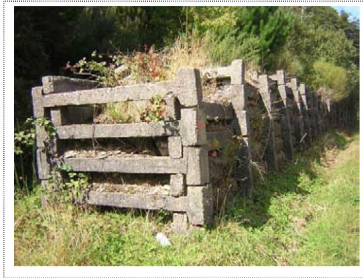
Figura 5.4: Muro de Contención de Suelos, Sector Santo Domingo, Salida Sur Valdivia.
