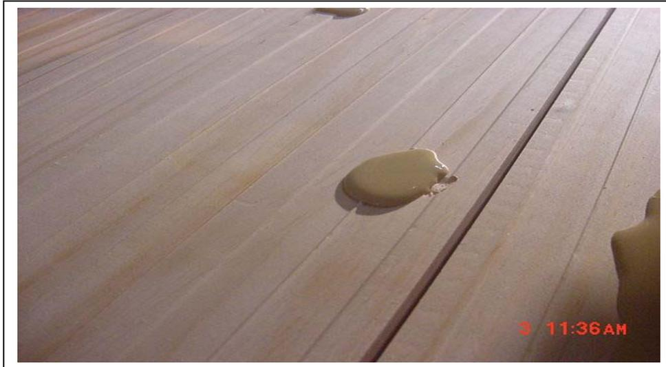
Figura 4: Molduras con un buen retape, listas para continuar el proceso.
