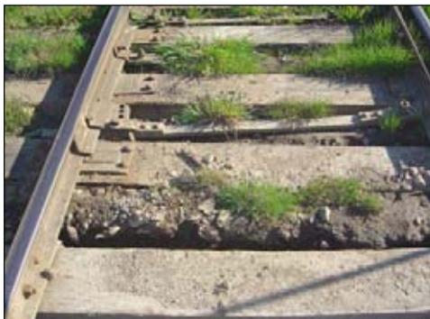
**Foto N° 7:** Los durmientes son utilizados para la construcción de las líneas férreas. Estos durmientes fueron fabricados con materiales y mano de obra de la zona.
