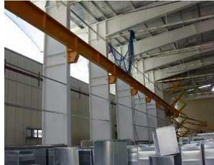
**Figura 3.13: Estructura metálica con pintura de terminación.**
