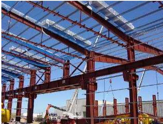
**Figura 3.5: Estructura de acero limpia de impurezas.**
