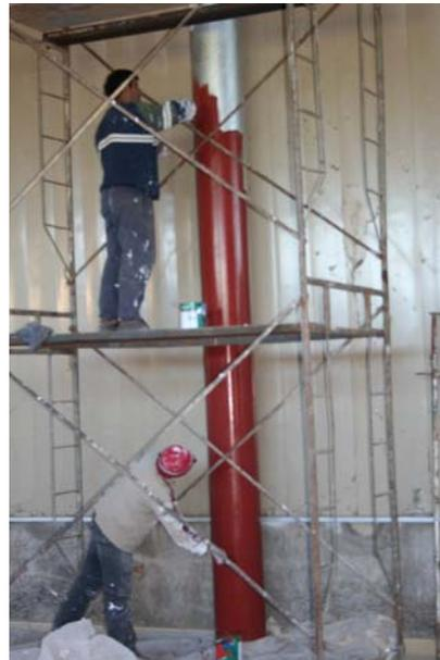
**Figura 3.7: Aplicación del imprimante en construcción de Serviteca de la ciudad de Los Ángeles.**
