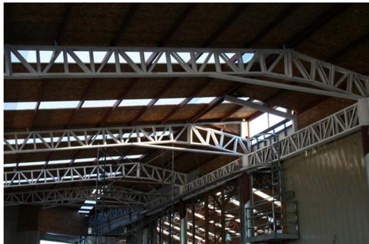
**Figura 3.24: Estructura galvanizada pintada con pintura intumescente.**
