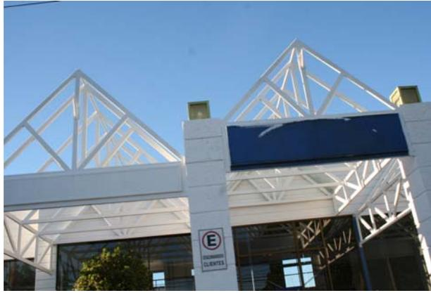
**Figura 4.9: Estructura pintada con intumescente directamente al sol.**
