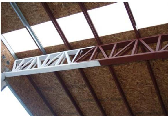
**Figura 3.9: Estructura imprimada y con pintura intumescente.**
