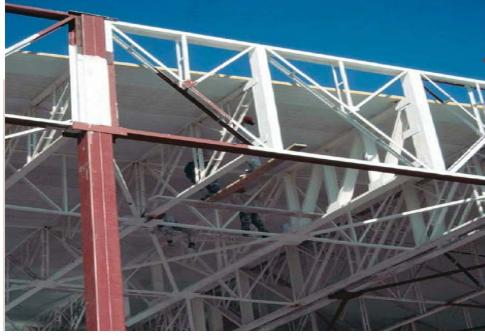
**Figura 4.7: Pintado de estructura metálica a la intemperie de cerchas en Cine Alto Las Condes.**
