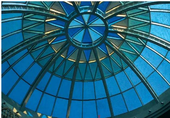
**Figura 4.11: Estructura metálica de techumbre en cúpula Mall Plaza Vespucio. Santiago.**
