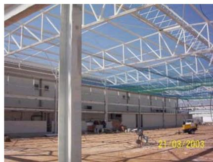
**Figura 3.11: Estructura metálica protegida con pintura intumescente.**
