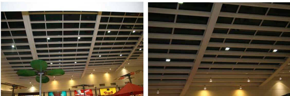
**Figura 4.12: Estructura metálica de techumbre de Mall Plaza de Los Ángeles.**
