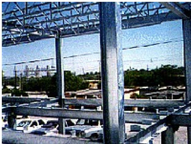
**Figura 3.21: Estructura de acero galvanizado sin pintar.**
