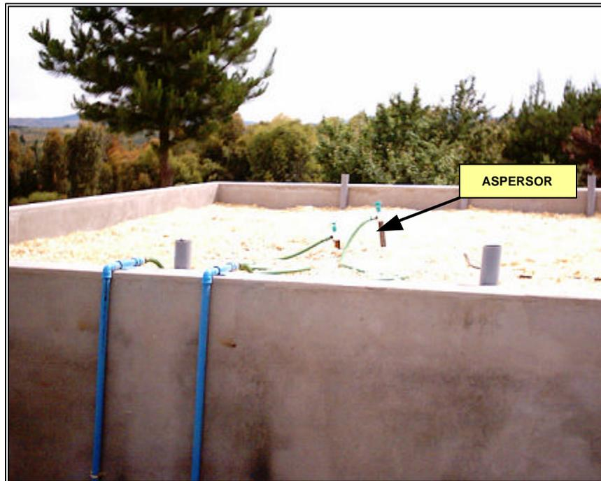
**FIGURA 4. Sistema Tohá (Sistema de distribución de agua con dosificador de flujo)**
