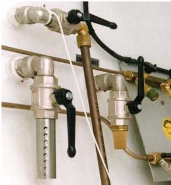
FIGURA N° 2-23 Válvulas de bola interior cámara.
