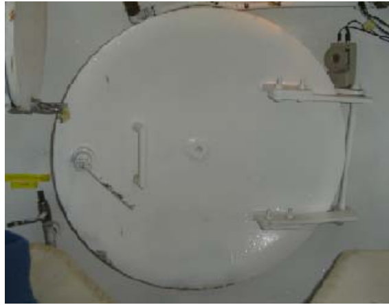
FIGURA N° 2-9 Vista interior de una escotilla.
