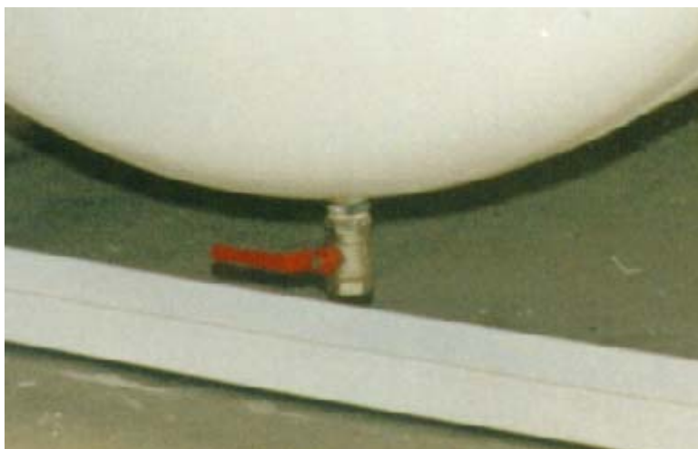
FIGURA N° 2-26 Válvula de purga.
