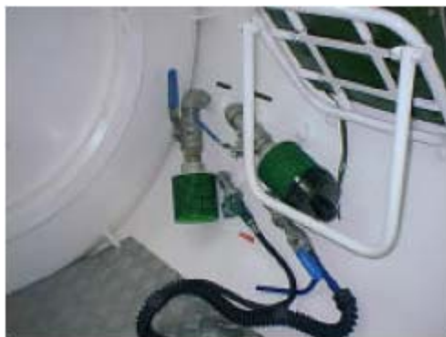
FIGURA N° 2-24 Silenciadores al interior después de una válvula de bola.
