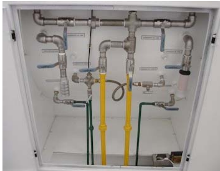
FIGURA N° 2-21 Suministro de gases cámara hiperbárica.
