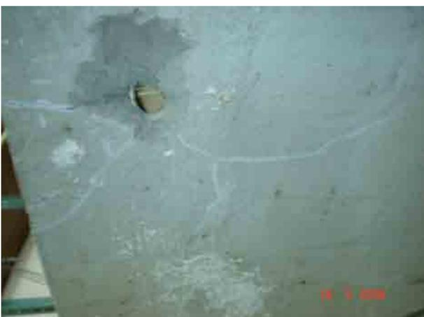
**Figura 9.36** Fisuras en zapatas.
