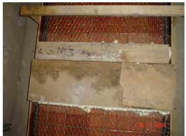
**Figura 8.17** Detalle del tramo sin hormigonar.
