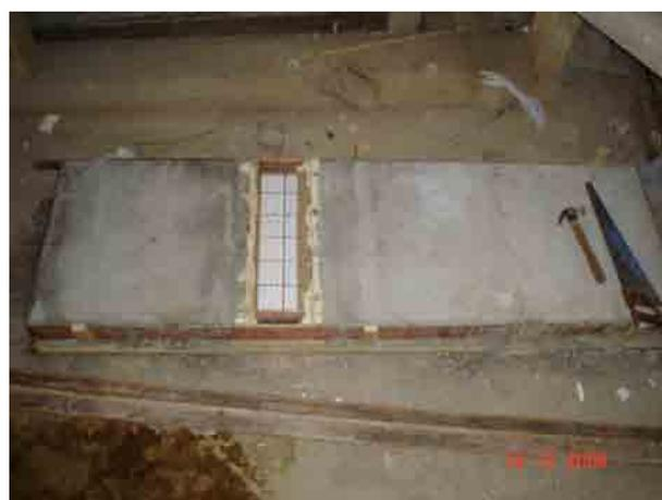
**Figura 8.25** Descimbre de la estructura.
