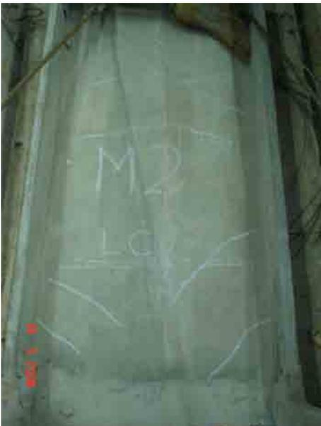
**Figuras 9.28 y 9.29** Fisuras en caras internas de los muros (superficie en compresión).
