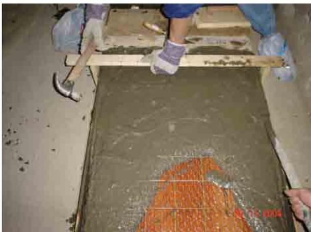
**Figura 8.18** Llenado y vibrado del mortero.
