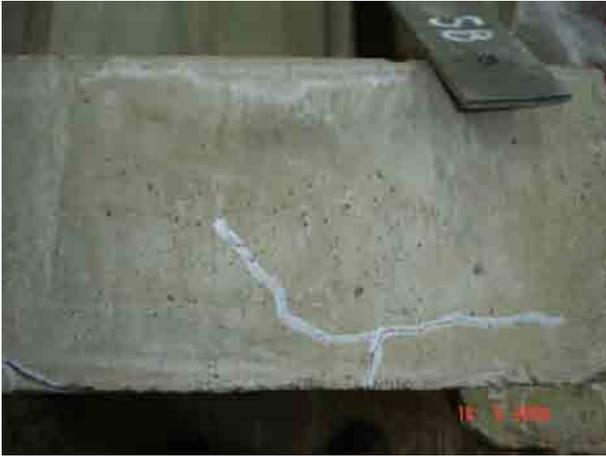
**Figura 9.38** Fisuras en zapatas.
