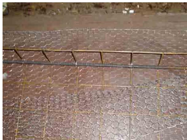
**Figura 8.10** Preparación de armaduras.
