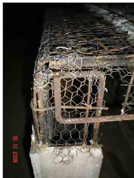
**Figura 8.37** Vista de suples instalados.
