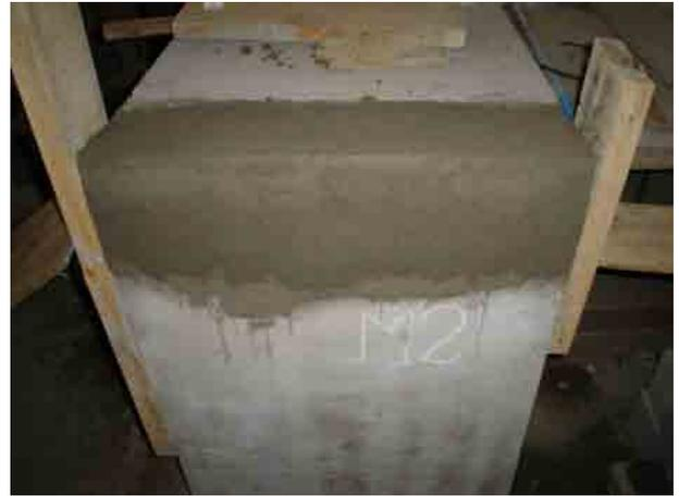
**Figura 8.41** Terminación y afinado de los muros.
