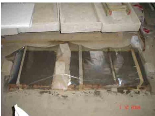
**Figura 8.22** Protección de muros para curado.
