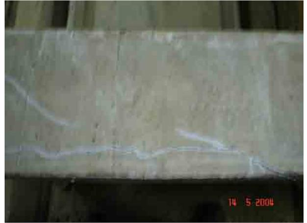
**Figura 9.39** Fisuras en zapatas.
