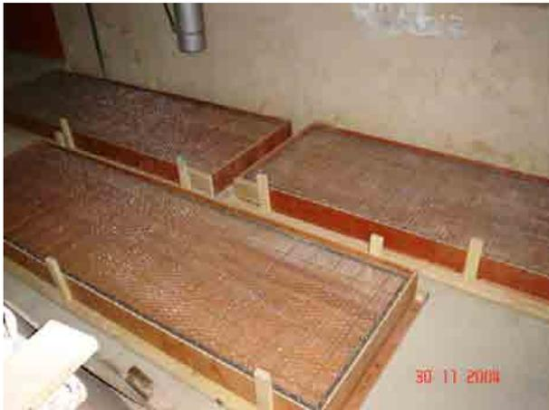
**Figura 8.14** Moldajes y armadura.
