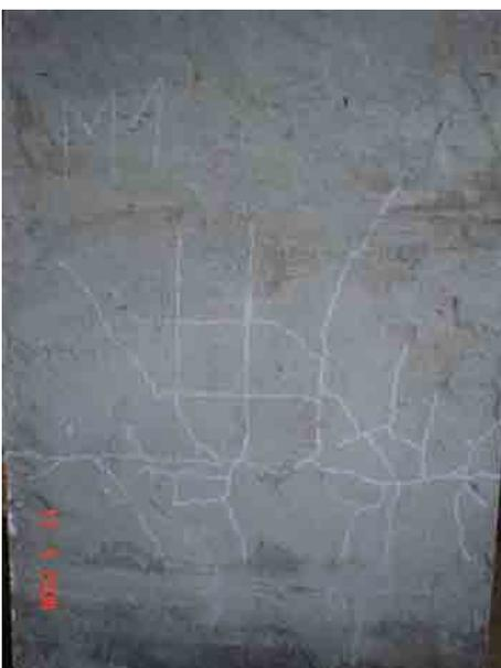
**Figuras 9.30 y 9.31** Fisuras externas del muro (superficie en tracción).
