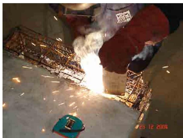
**Figura 8.35** Fijación de suples para forma final.
