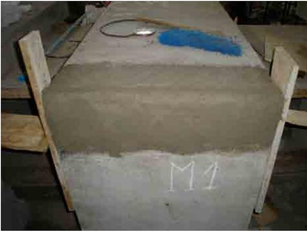
**Figura 8.40** Terminación y afinado de los muros.
