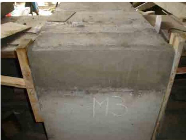
**Figura 8.42** Terminación y afinado de los muros.
