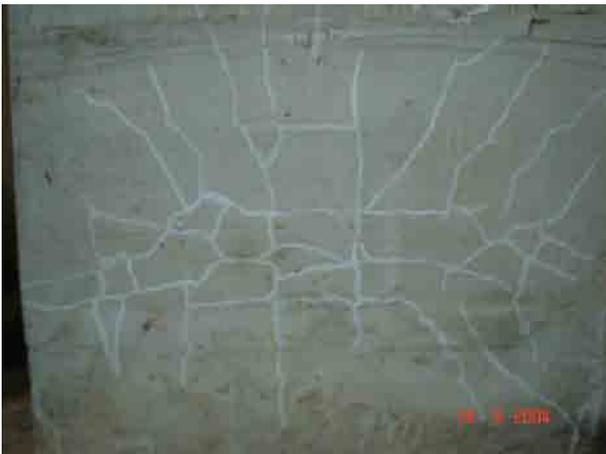
**Figuras 9.34 y 9.35** Fisuras externas del muro (superficie en tracción) luego del colapso y en la base del muro.
