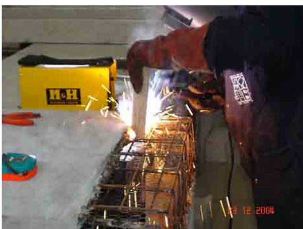
**Figura 8.34** Fijación de suples para forma final.
