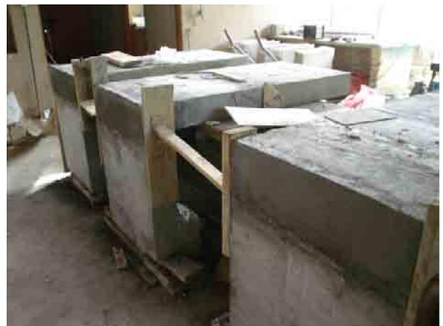
**Figura 8.43** Terminación y afinado de los muros.
