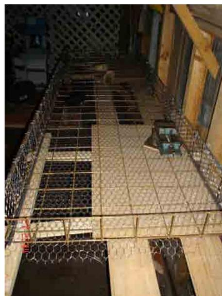
**Figura 8.12** Preparación de armaduras.
