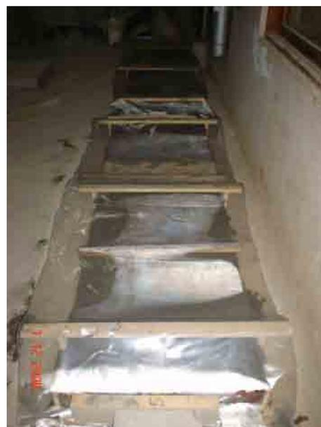
**Figura 8.23** Protección de muros para curado.
