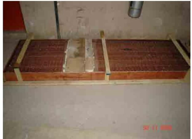
**Figura 8.15** Moldaje listo para hormigonado.
