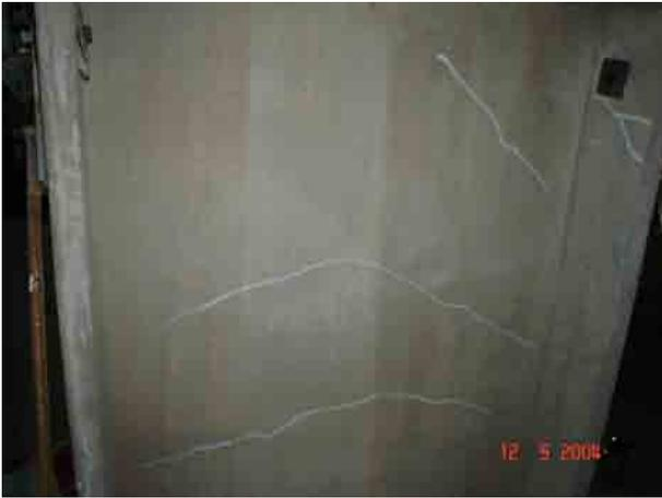
**Figura 9.26 y 9.27** Fisuras en caras internas de los muros (superficie en compresión).
