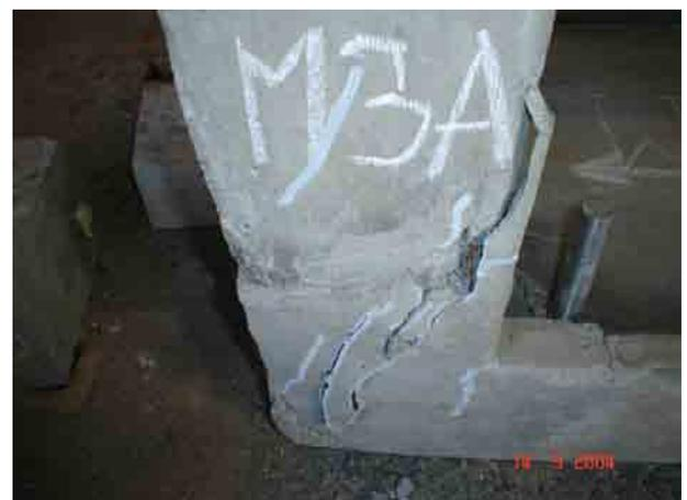
**Figuras 9.48 y 9.49** Fisuras externas del muro
