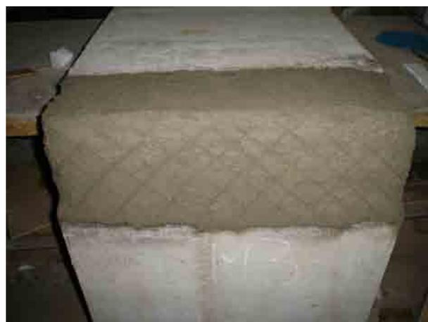
**Figura 8.39** Hormigonado a mano de los muros.
