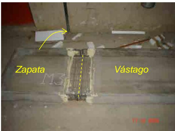
**Figura 8.30** Muros desmoldados.
