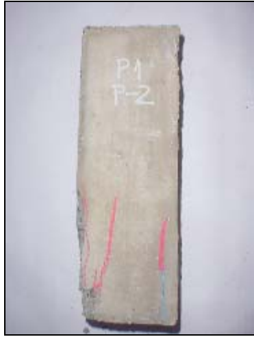
Foto 4.2 3 Grietas pilar prototipo
