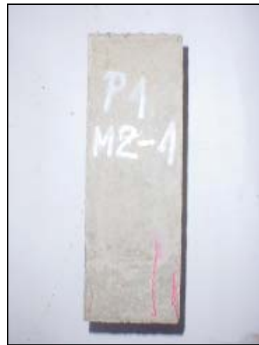
Foto 4.2 5 Grietas pilar modelo 2
