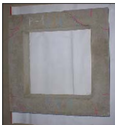
Foto 4.3 2 Grietas estructura 1 prototipo
