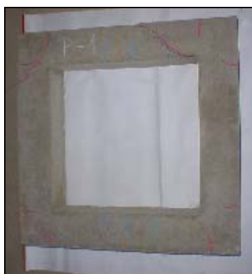
Foto 4.3 2 Grietas estructura 1 prototipo
