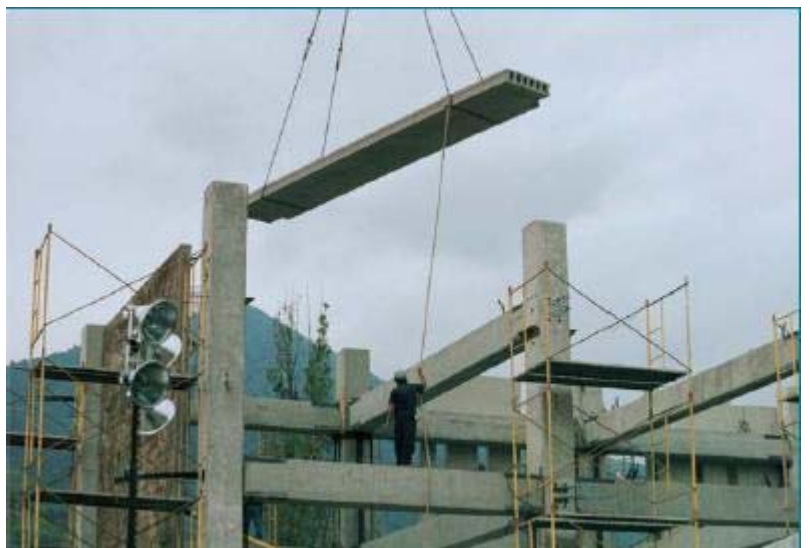
Fig.2.0 Instalación de Losas Pre-tensadas Prefabricadas, para Edificio con Marco de Momentos Resistentes.
