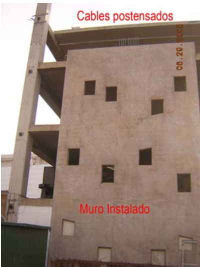
Fig. 2.7 Elevación de Muros Prefabricados con Sistema Tilt-Up , y postensado con cables en la mitad de su ancho, Foto Edificio Prefabricado Expo-Hormigón Espacio Riesco, Santiago-Chile.
