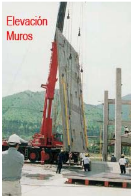
Fig. 2.5 Montaje, Sistema Tilt-Up de Muros Prefabricados.
