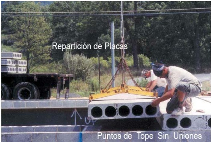
Fig. 2.4 Instalación Sobre Apoyos de Placa Prefabricada.
