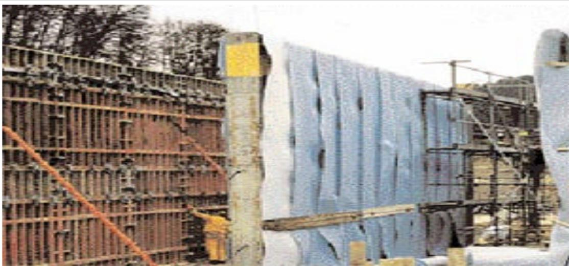
**Figura 5.1, Lona protectora que cumple la función de .proteger el hormigón**
