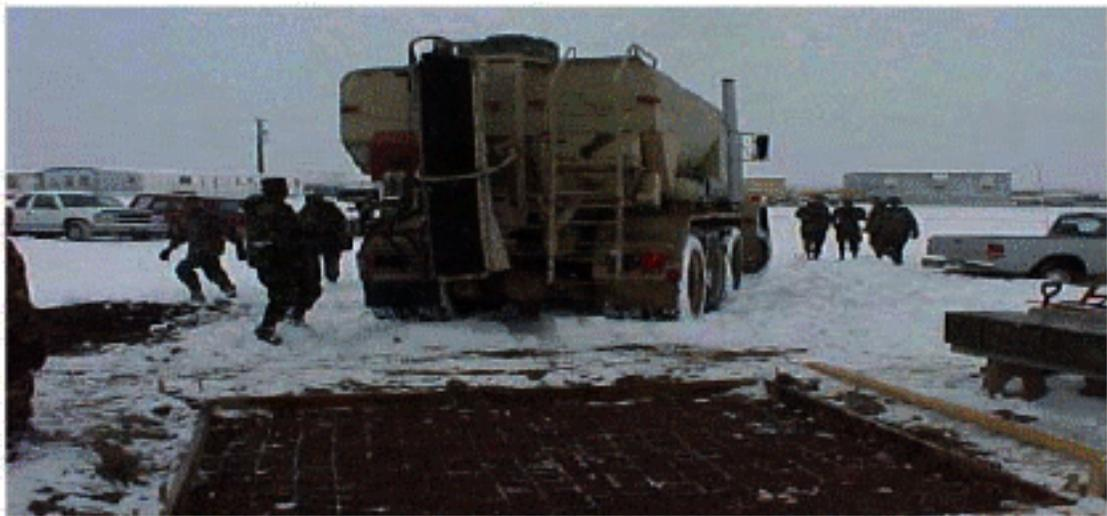
**Figura 3.3, Retiro de la nieve previo a colocar el hormigón.**
