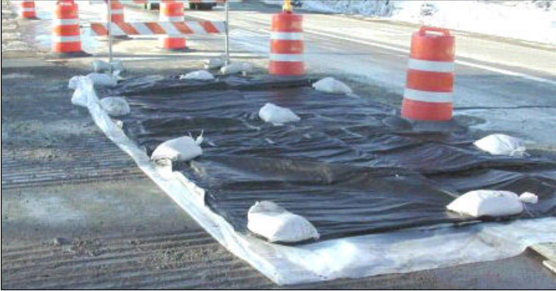
**Figura 5.2, Estas mantas aislantes tienen una mayor densidad por ello mas eficiente en la retención del calor de hidratación**
