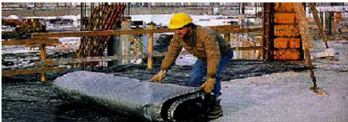
**Figura 5.2, Estas mantas aislantes tienen una mayor densidad por ello más eficiente en la retención del calor de hidratación**
