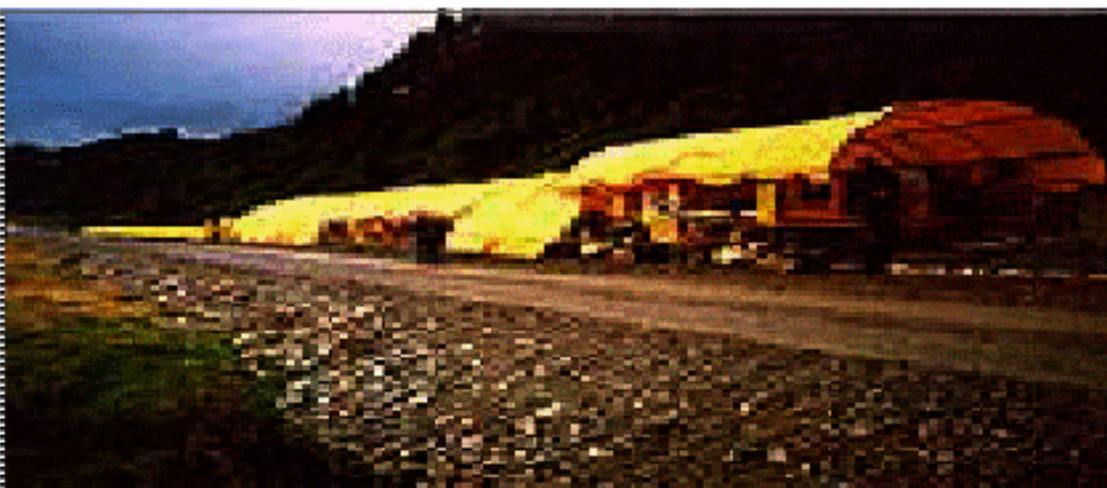
**Figura 3.4, Protección de las zonas que se están hormigonando, así también se crea un microclima para proteger el hormigón.**
