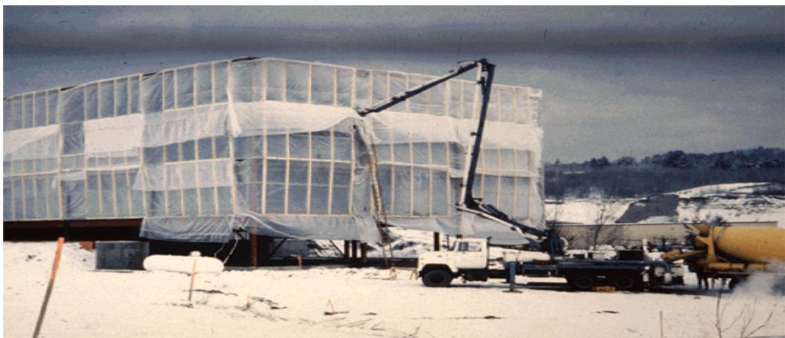
**Figura 3.5, Cierros utilizados como protección y sirve para crear microclima en el interior.**
