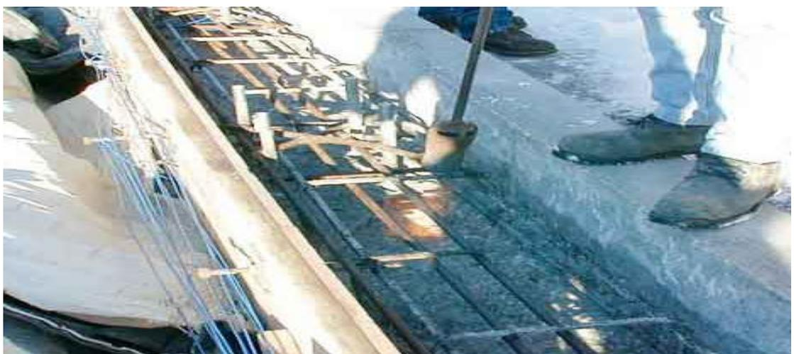
**Figura 4.1, Retiro de escarcha y sobrecalentamiento de la armadura, para que la temperatura del hormigón y de la armadura se encuentre casi a una misma temperatura.**
