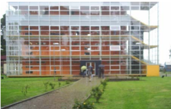
Una vez dada la alarma, se comenzó rápidamente la evacuación.
