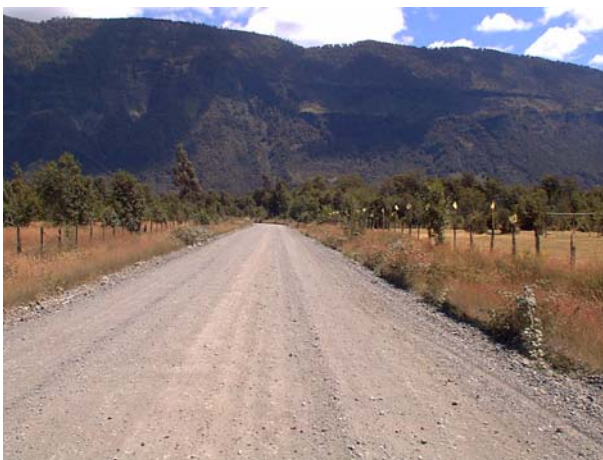
ESTADO INICIAL DEL CAMINO
