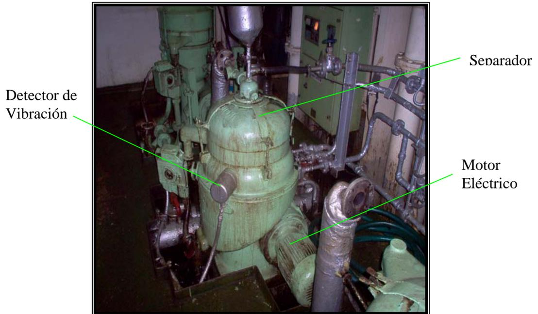
**Figura 38.- Separador centrifugo de IFO.**
