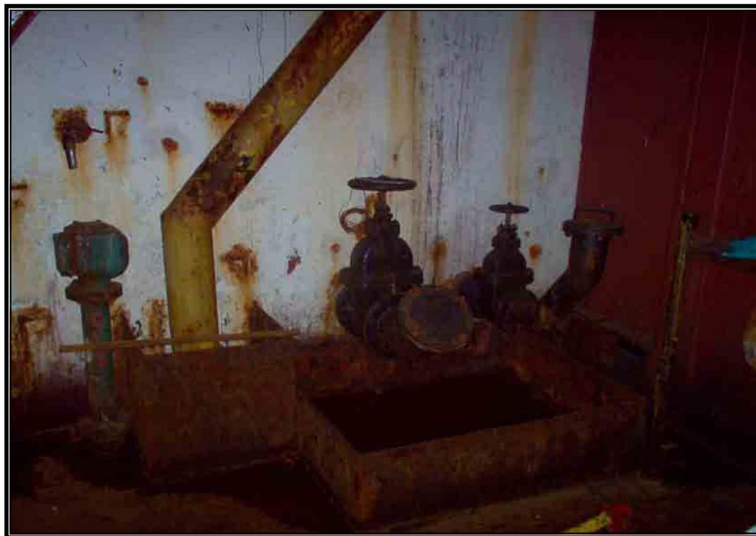
**Figura 30.- Tomas en cubierta para Faena de combustibles.**
