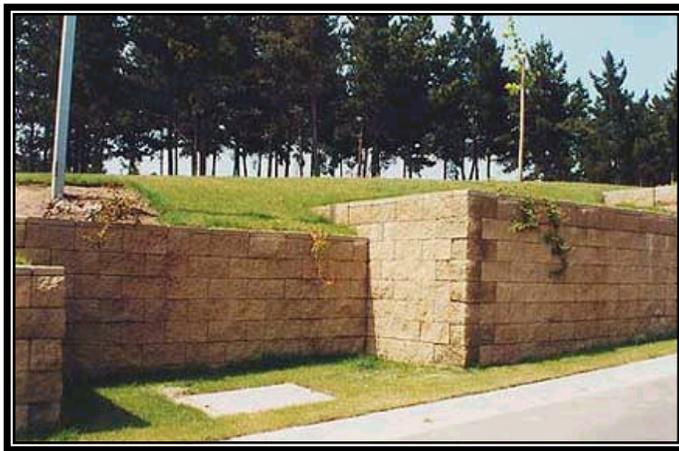
**Foto N° 42. Aplicación de los bloques con pigmento de hormigón, para la construcción de muros de contención.**
