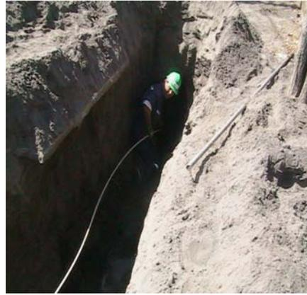
Antes de comenzar el tiro se debe pasar un cable de fibra, denominado “cobra”, este debe pasar por el interior de la tubería existente y tiene la finalidad de verificar el real estado de la tubería madre, que facilitará la entrada del cable de acero del winche en la tubería a reemplazar.
