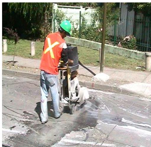
Una vez identificada la unión domiciliaría se procede a cortar la calzada, con el propósito de dejar funcionando, en menor tiempo posible la conexión con la red de alcantarillado público y así no alterar el funcionamiento normal de los hogares.
