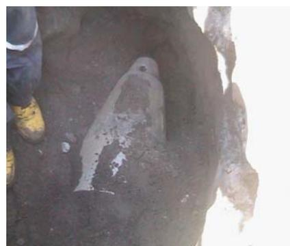
Después de cierto tiempo mientras se instala la tubería el expansor aparece en la cámara de llegada, lo que indica que nuestro tiro ha finalizado, proceso continuo es el de extraer la bala de la cámara.
