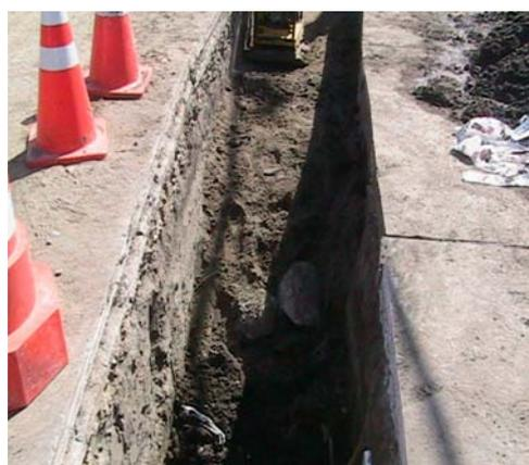
Preparación del pozo de ataque o ventana Cracking por la cual ingresará la bala que es la que arrastra la nueva tubería de HDPE, que reemplaza en forma instantánea a la tubería antigua. Las dimensiones varían según el tipo de terreno, la pendiente de la tubería existente, el flujo vehicular, entre otros.
