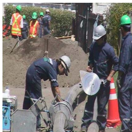
En estas imágenes se ve la unión física de dos tuberías de HDPE, esto se realiza hasta alcanzar el metraje necesario para realizar la renovación del tramo. Esta unión se realiza mediante el proceso de termofusión.
