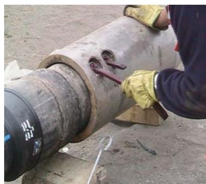
Luego de haber definido el lugar del pozo se procede a la preparación de la bala y su expansor definitivo, el cual arrastrará la nueva tubería, dicha preparación consiste en una limpieza de la maquinaria y herramientas: bala, expansor, mangueras, stub end (unión entre la bala y la tubería). Para proseguir con la unión entre la herramienta y la tubería de HDPE, la cual deberá realizarse con personal especializado y capacitado para evitar riesgos y accidentes.
