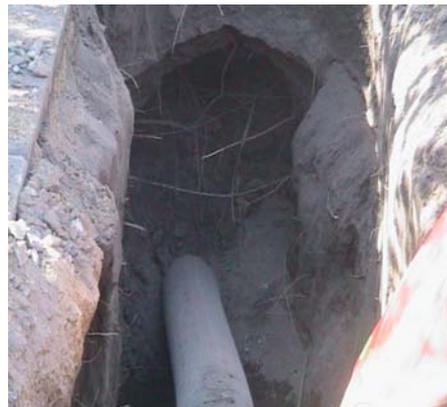
Una vez que está todo preparado se ubica la bala con el tubo fusionado en la boca del tubo existente, se tensa lentamente el winche para ayudar en este trabajo, una vez instalada la herramienta en el interior de la tubería vieja estaría todo listo para comenzar el tiro, se procede a abrir el paso del aire, con esto comienza el Cracking.
