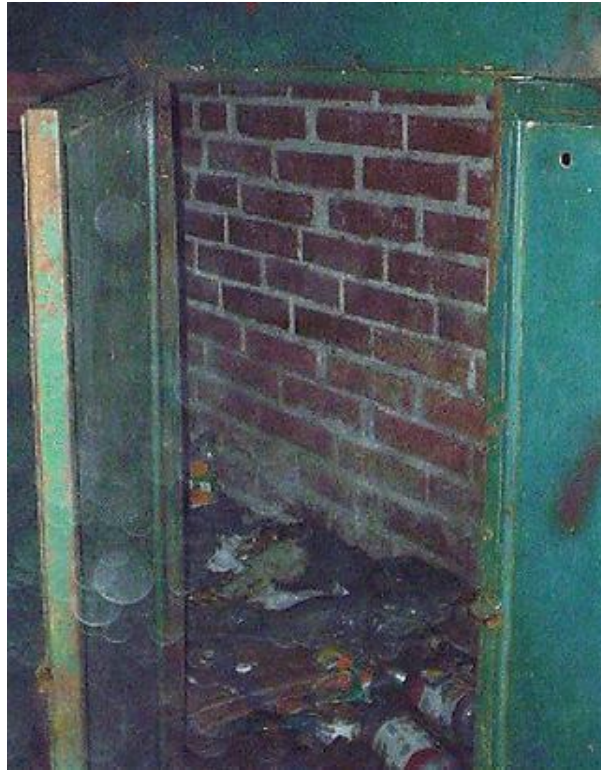
Bodega de almacenamiento de los contenedores de basura del Hotel Isla Teja. Junio 16, 2004.
