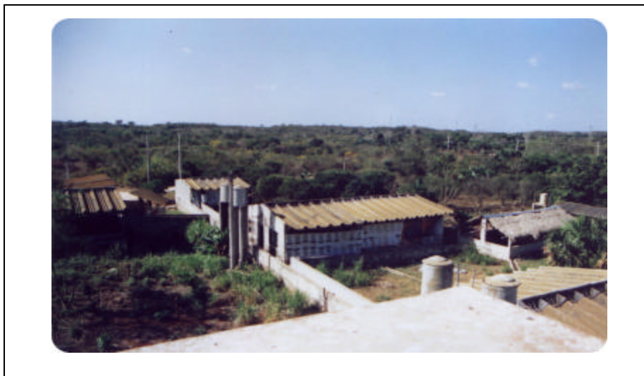
Fotografía 1. Vista aérea de las instalaciones de maternidad y destete, en la granja San Miguel SPR de RI, Maxcanú, Yucatán, México.
