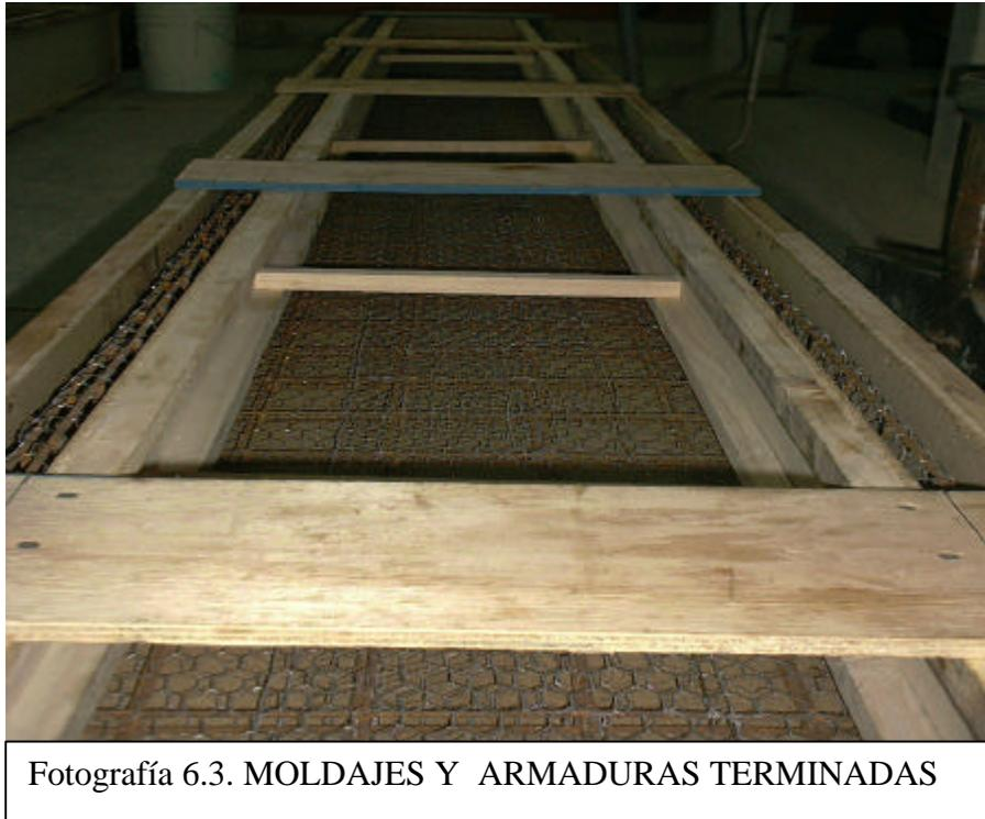
Fotografía 6.3. MOLDAJES Y ARMADURAS TERMINADAS
