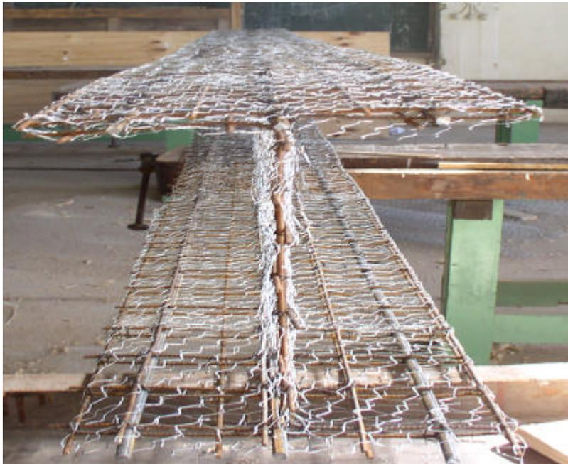
**Fotografía 6.2. ARMADURA TERMINADA**
