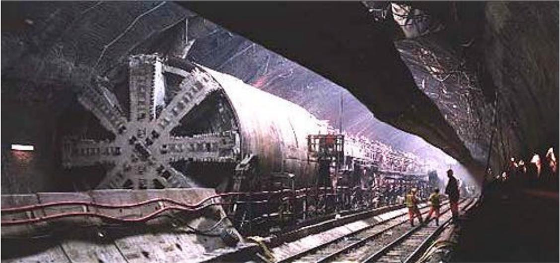
Fig. 3.15 TBM usada en el Canal de la Mancha
