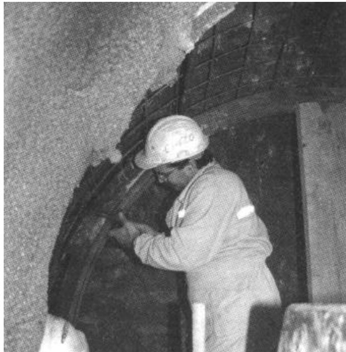
Fig. 3.29 *Sostenimiento mixto (cerchas, mallas y hormigón proyectado)*
