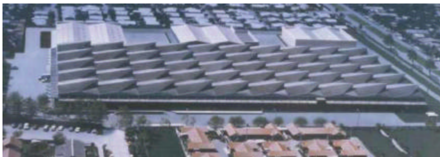
FIGURA N°1.1. Instalaciones planta Sindelen.
