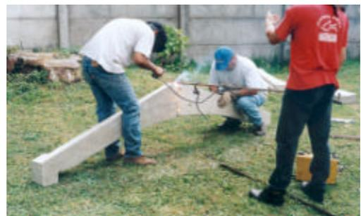
Foto 14. Ejecución de unión de vigas
