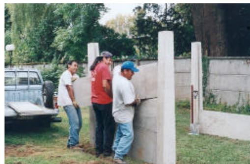
Foto 10. Instalación de placas laterales
