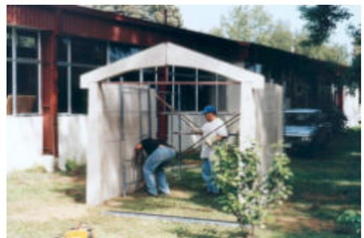
Foto 17. Unión entre pilares y vigas
