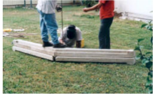
Foto 15. Preparación del segundo juego de vigas, usando a las que ya están unidas como p lantilla
