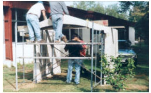
Foto 16. Montaje de las vigas
