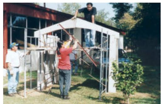
Foto 22. Instalación de arrostramientos
