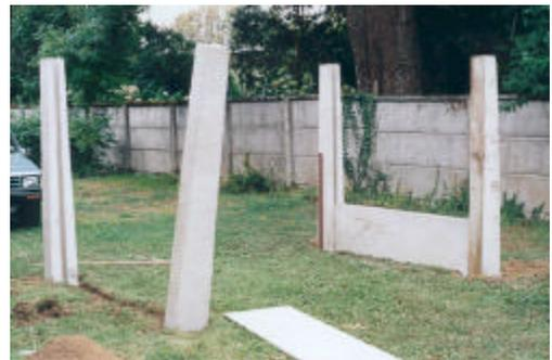
Foto 8. Instalación de pilares
