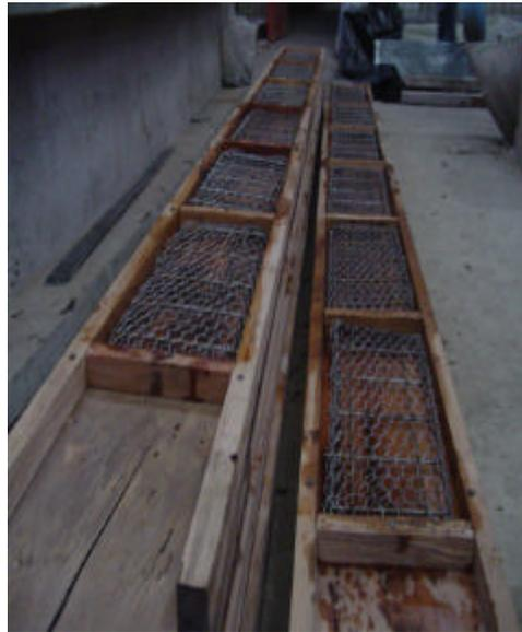
Fotografía 3.3 *Moldaje con armadura*
