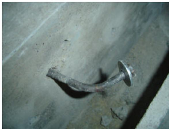
Fotografía 4.10 *Deformación del Perno*
