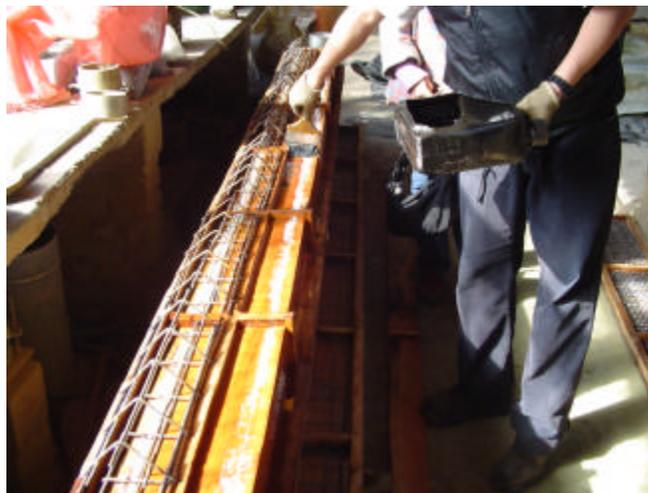
Fotografía 3.1 *Aplicación desmoldante*
