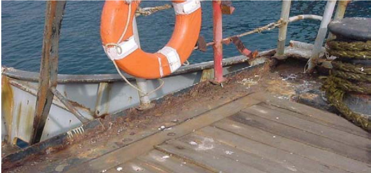
Altos niveles de corrosión en cubierta.
