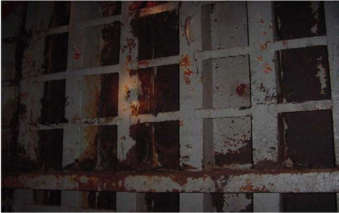
Corrosión en bodega por presencia de humedad.
