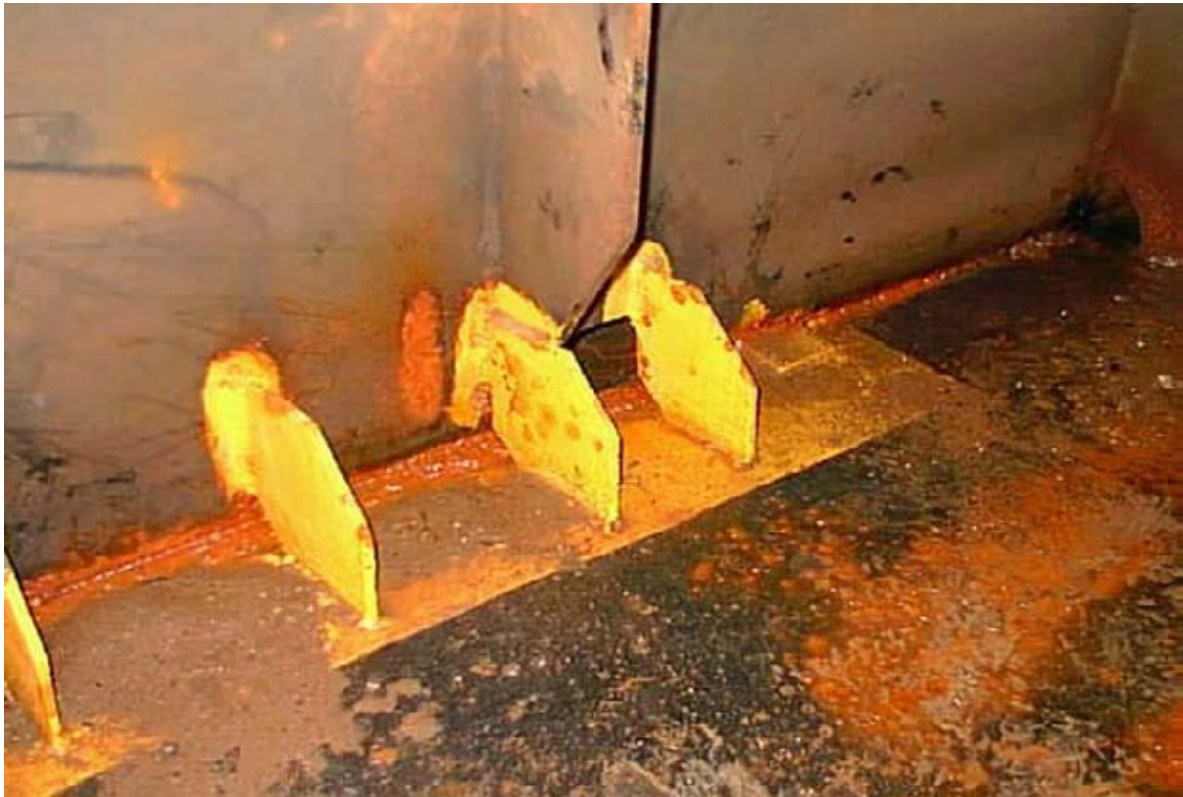
Presencia de de puntos duro producida por cartabones en la plancha de fondo.
