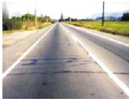
FIG. 15 -FISURAS DE REFLEXIÓN
