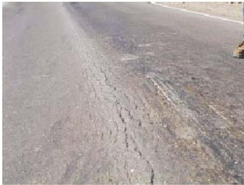
FIG. 20 -FISURAS DE DESPLAZAMIENTO
