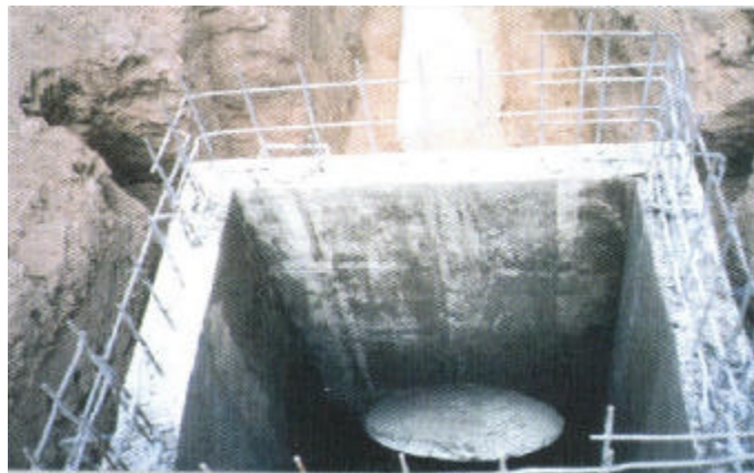
Figura 23. Llegada de tubo a cámara.
