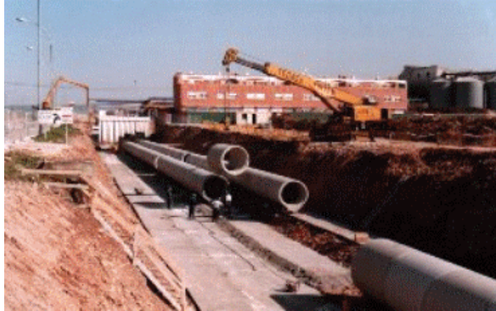
Figura 29. Utilización de maquinaria para la colocación de tubos de hormigón.
