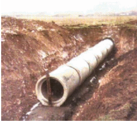
Figura 30. Colocación de tubos de hormigón de base plana, en dirección aguas arriba
