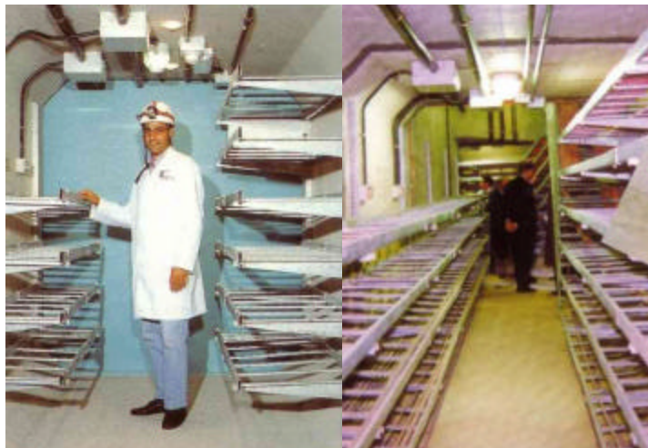
Fig.16. Disposición de Redes interior de Galería Techo Plano
