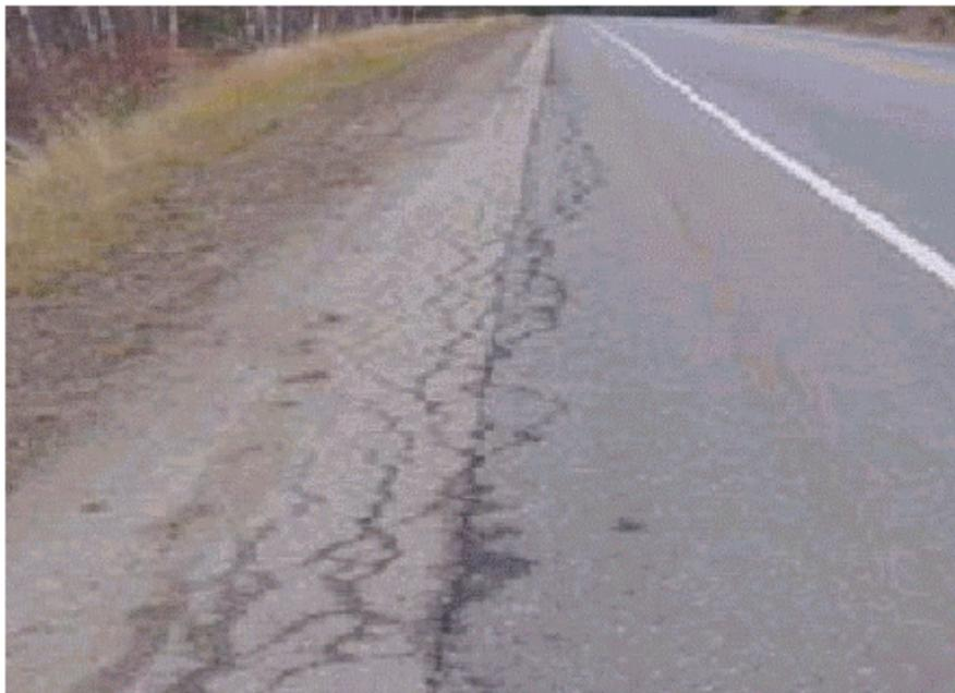
Los problemas asociados que trae como consecuencia es el bombeo, la infiltración de agua, la irregularidad del pavimento, la pérdida de resistencia estructural y algo muy importante que se pierde el ancho de la calzada.
