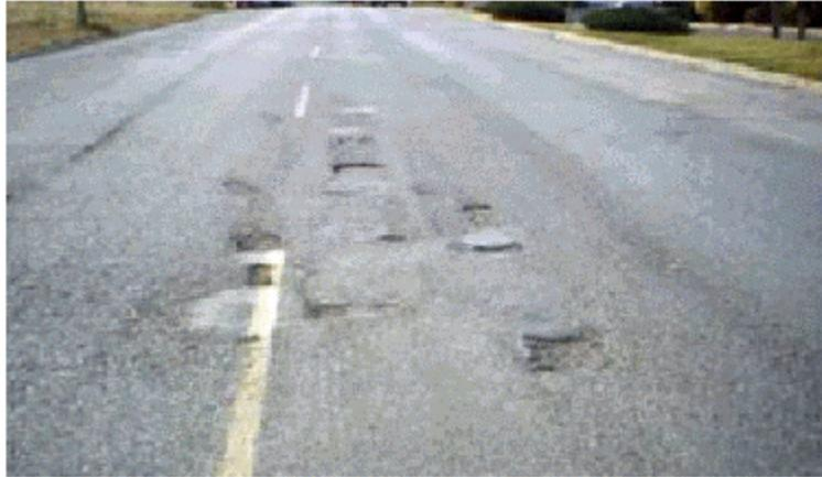
Se dividen en leves que son de una profundidad de menos de 25 mm, moderada entre 25 a 50 mm y la alta de mas de 50 mm.
