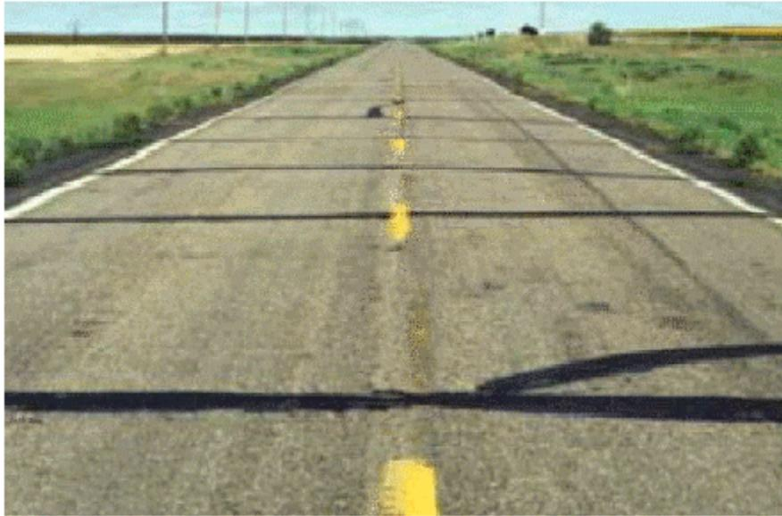
Problemas asociados son la infiltración del agua a la infraestructura, la pérdida de resistencia estructural y por supuesto las irregularidades del pavimento. Esto se puede resolver aserrando y sellando las grietas o simplemente la reconstrucción.
