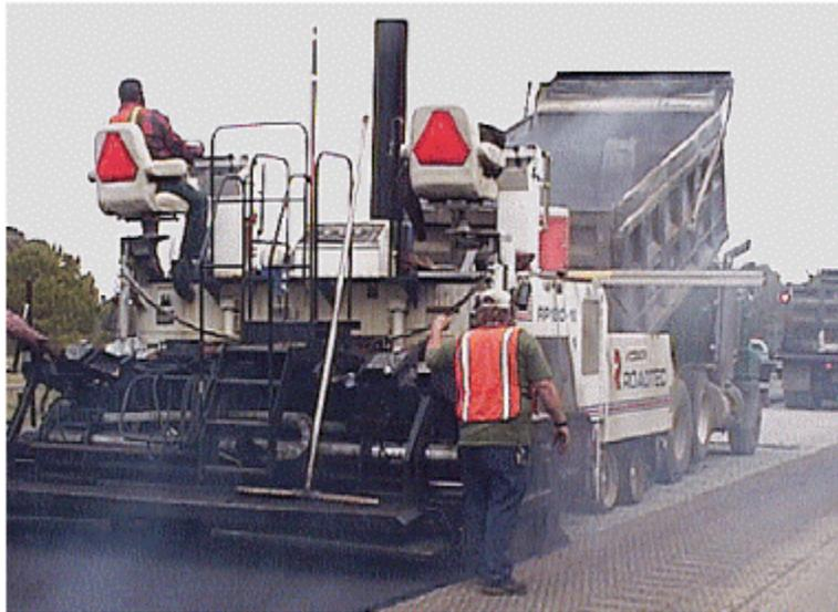
Una vez que la mezcla haya sido tendida, enrasada y alisada esta debe ser compactada en forma uniforme por rodillos compactadores.
