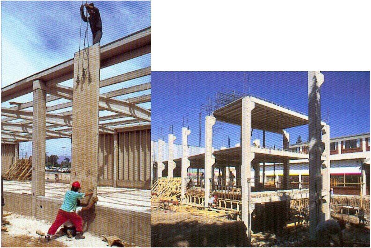
**Figura 2.6:** Detalle de montaje de losetas "Pi".
