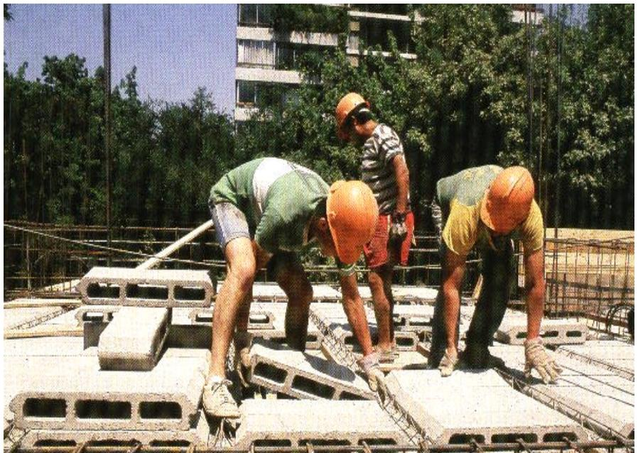
**Figura 2.5.2:** Colocación en obra de loseta tralizada.
