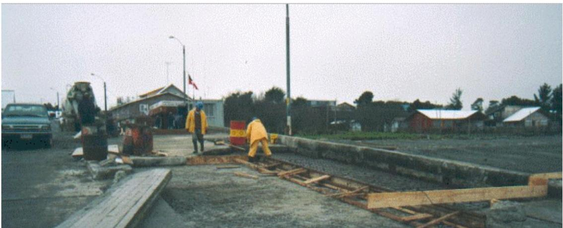
Colocados estos moldajes, se verifica la altura o espesor de la carpeta, mediante la colocación de una barra metálica (igual a la altura de la carpeta), la cual en sus extremos se apoya y desplaza sobre los moldajes y muros de la rampa.
