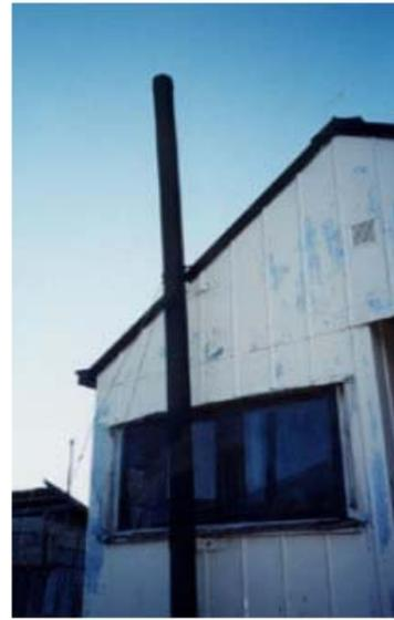
La ventilación de las cámaras y el control de olores en la USS funcionan según el siguiente principio: las cámaras son construidas de manera absolutamente hermética, dejando sólo dos accesos de aire: a través de la entrada de por la taza (al interior de la caseta o de la casa) y a través de la salida superior del tubo de ventilación. La circulación
