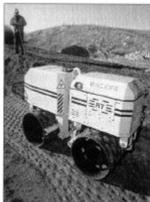
Fig 42. Compactación con un rodillo para zanjas
