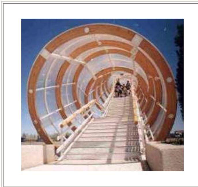
Fig. N° 48. – Aplicación de placas de policarbonato compacto (4,5 mm). Vista frontal, paso nivel peatonal, Concepción.
