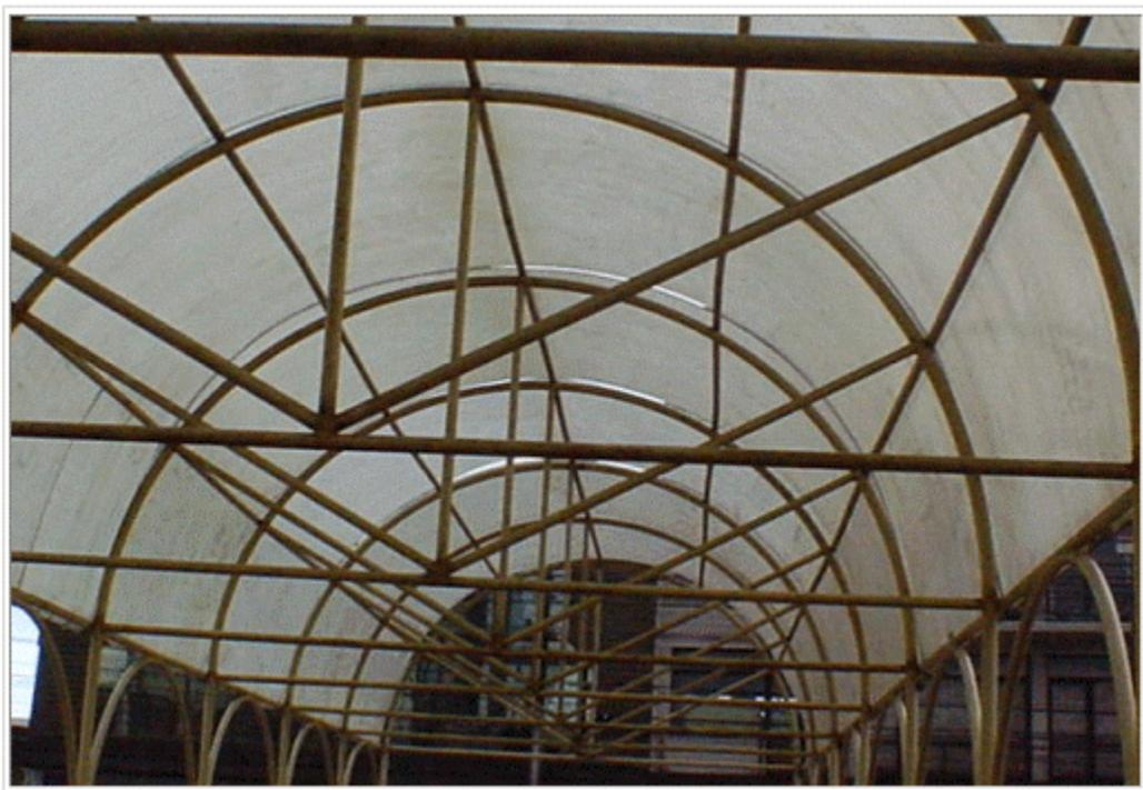
Fig. N° 88. – Falta de un elemento de unión entre placas.
