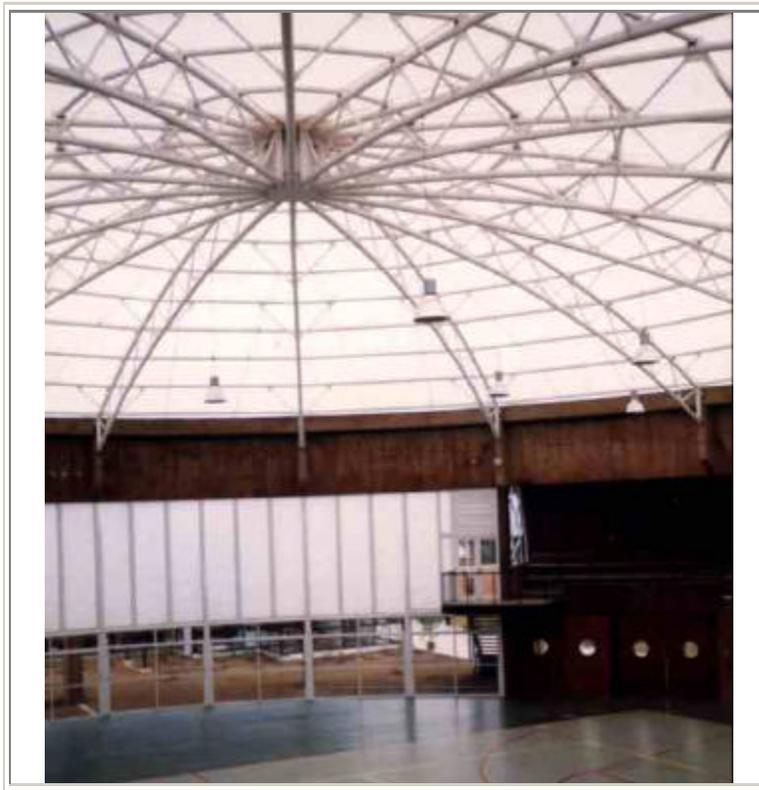
Fig. N° 54. – Aplicación de policarbonato alveolar 10mm blanco y compacto 4.5mm transparente en Gimnasio de Colegio, Coya.
