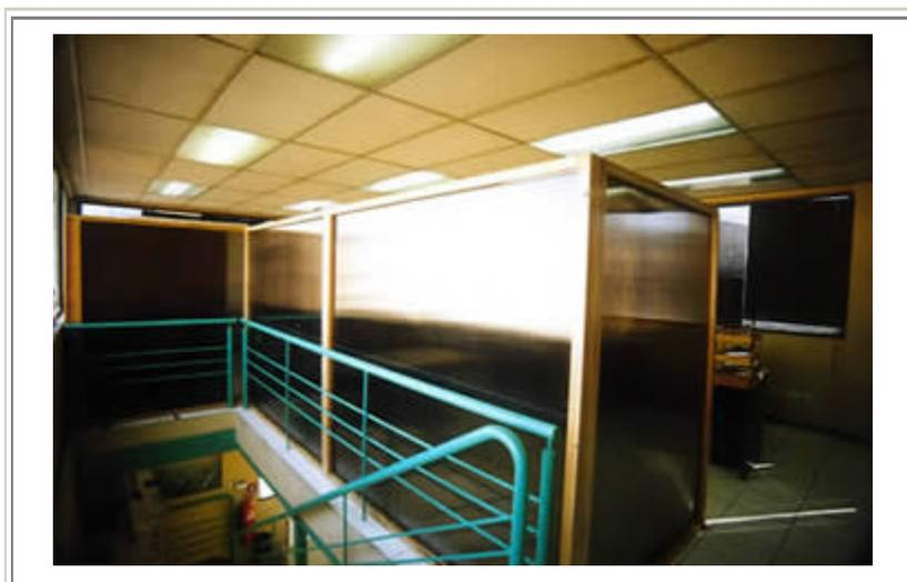
Fig. N° 51. – Separador de ambiente (Biombo), policarbonato alveolar 10 mm bronce con marcos de madera.
