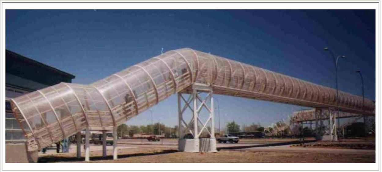
Fig. N° 49. – Aplicación de placas de policarbonato compacto (4,5 mm). Vista lateral, paso nivel peatonal, Concepción.
