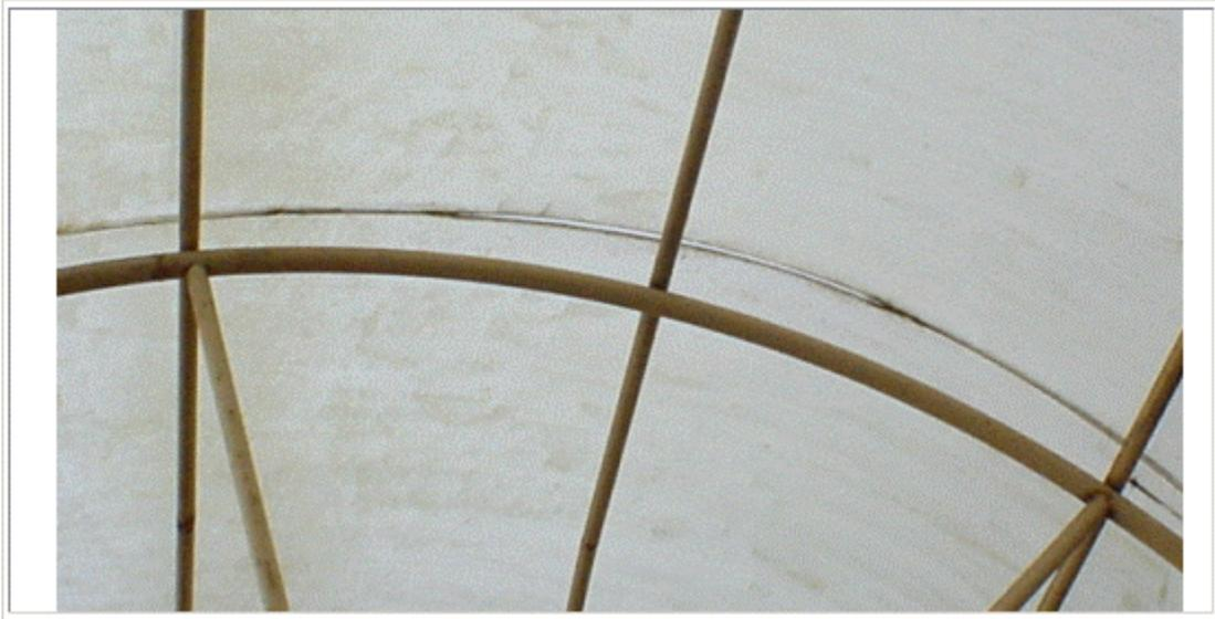
Fig. N° 89. – Detalle de la ausencia del perfil H en la unión entre placas.
