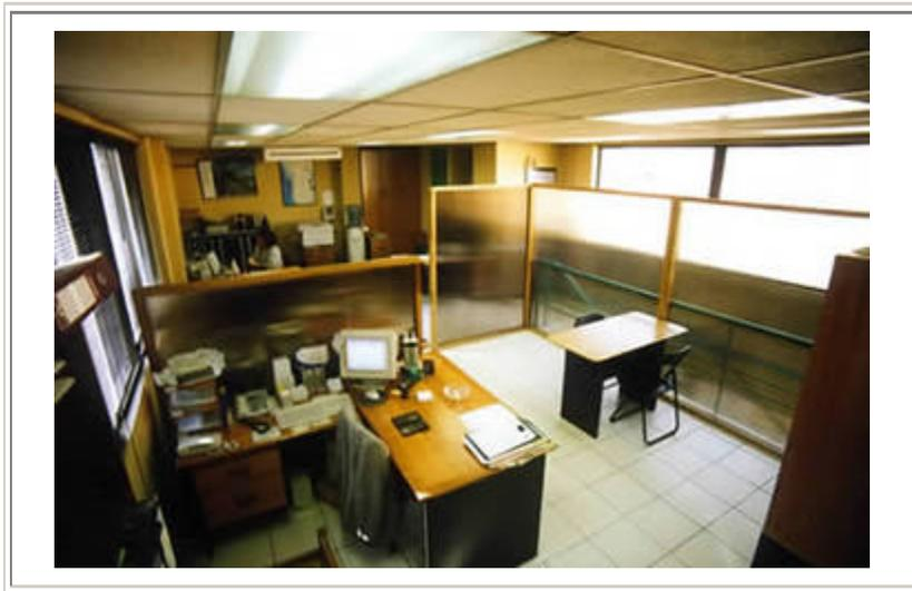
Fig. N° 52. – Separador de ambiente (Biombo), policarbonato alveolar 10 mm bronce con marcos de madera.
