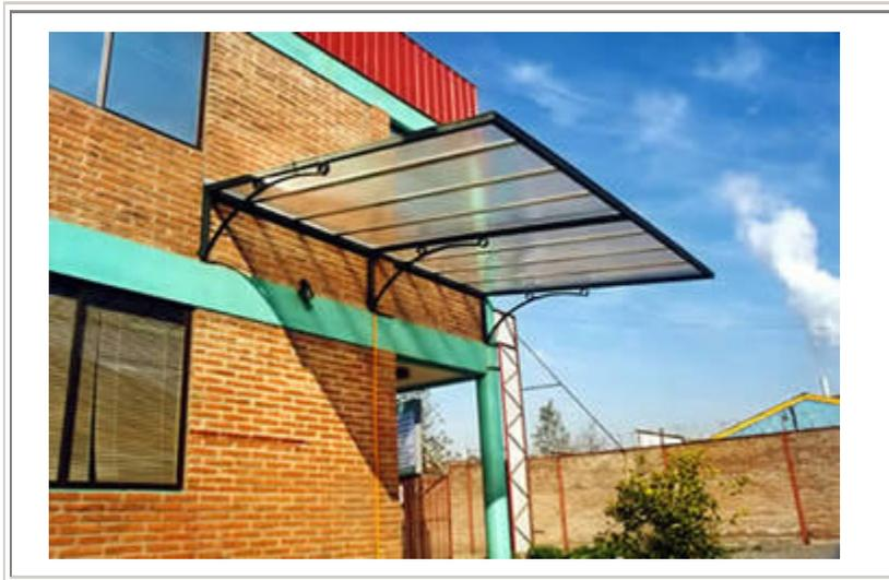
Fig. N° 50. – Techo modular autosoportante, policarbonato alveolar 4mm clear.
