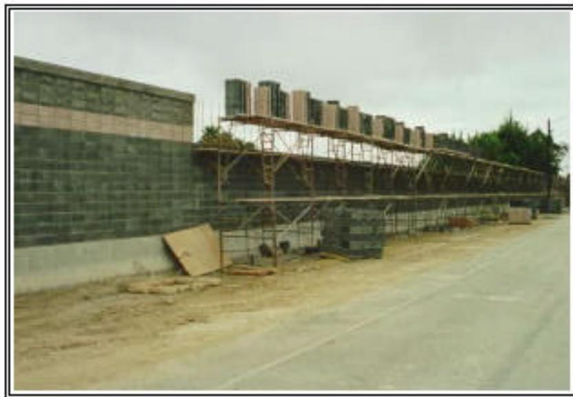
**Figura 4.26. Barrera de ladrillo tipo albañilería.**
