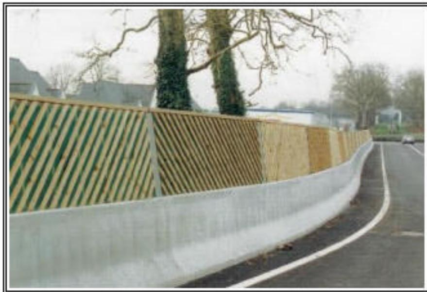
**Figura 4.29. Barrera de madera absorbente.**
