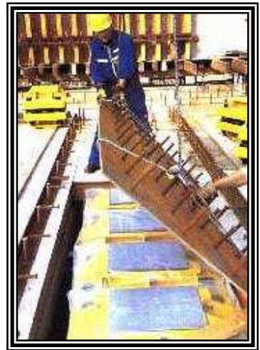
Fig. 2.95 Recubrimiento de las unidades de resorte con una placa de acero.
