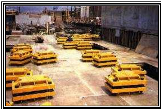
Fig. 2.90 Apoyos de resorte a punto de su colocación
