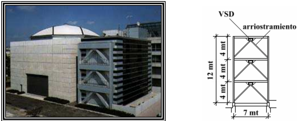
Figura 3.14 Edificio KaTRI N°21 (izquierda) y su sección transversal (derecha).
