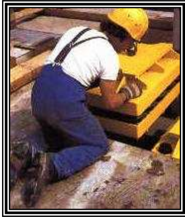
Fig. 2.92 Colocación de unidades de resorte.
