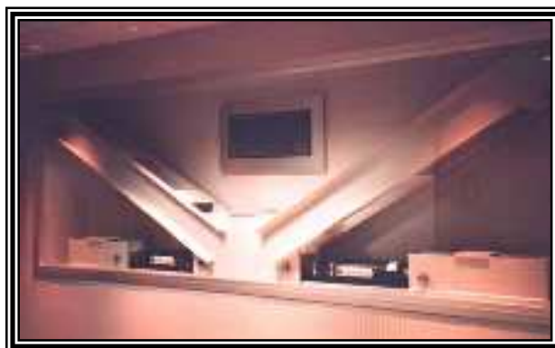
Figura 2.40 Instalación de amortiguadores en el Centro de Operaciones del Pacific Bell.
