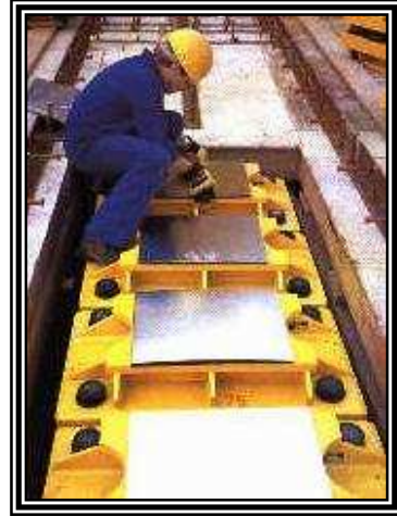
Fig. 2.93 Colocación de placas espaciadoras.
