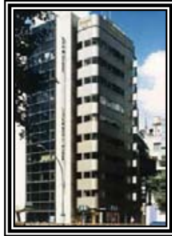
Figura 3.9 Edificio Kyobashi Seiwa.
