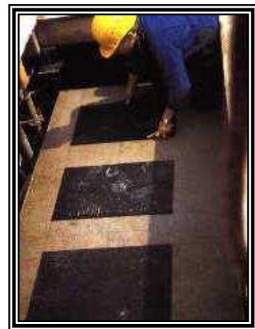
Fig. 2.91 Colocación de placas autoadhesivas inferiores
