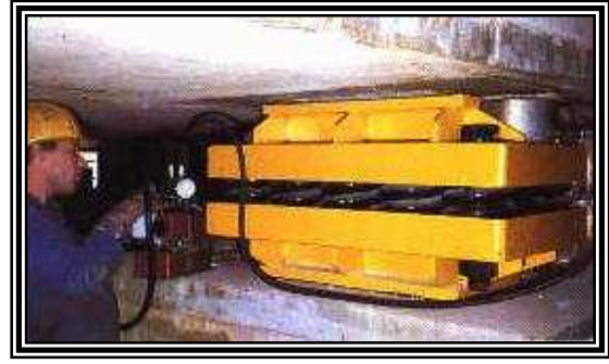
Fig. 2.99 Elevación de las unidades de resorte con gatas hidráulicas.
