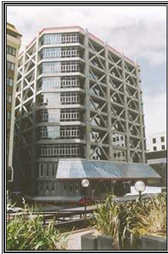
Figura 2.15 Estación de Policía Central de Wellington.
